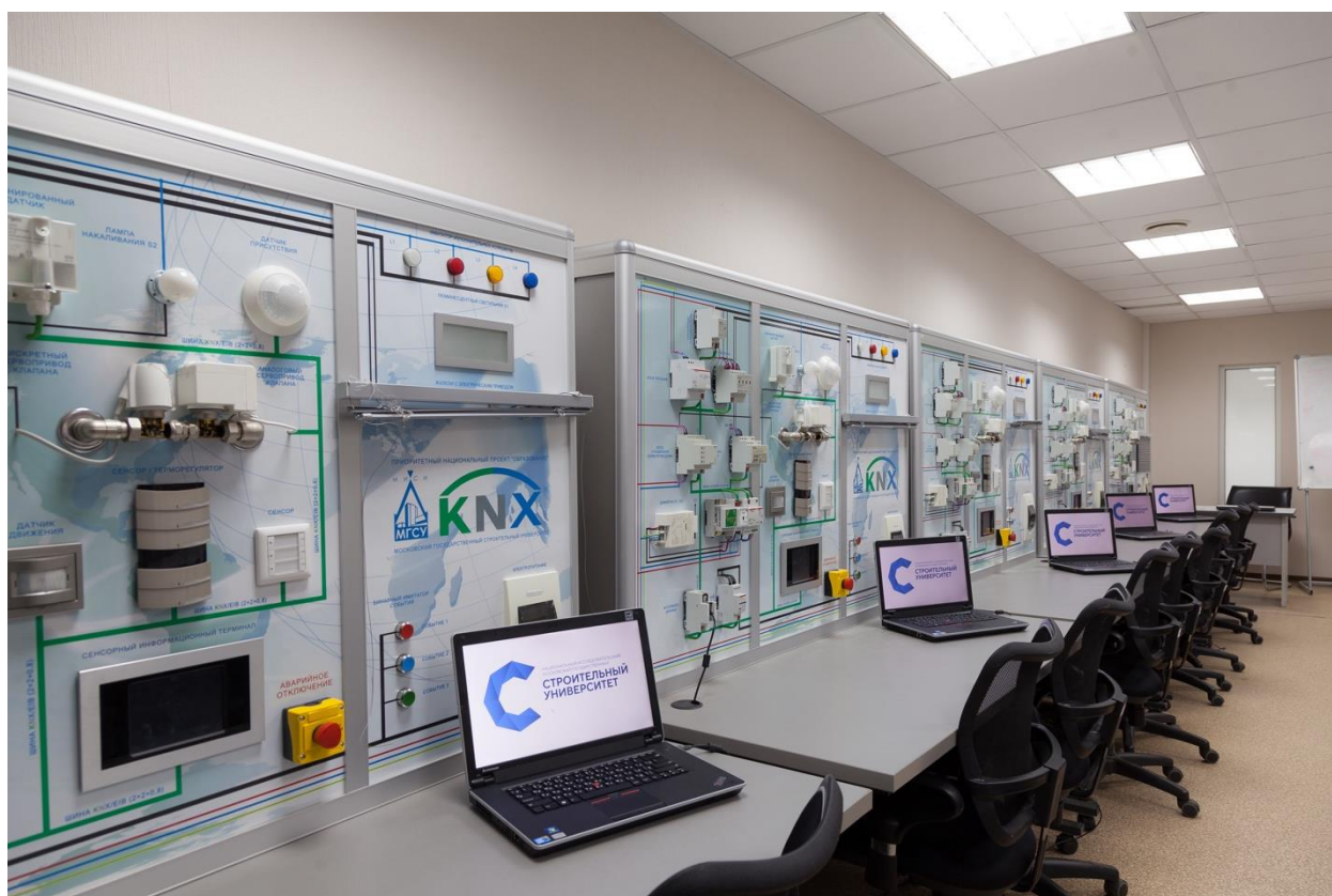
Рис. 5 Общий вид Лаборатории автоматизированных систем управления зданиями
