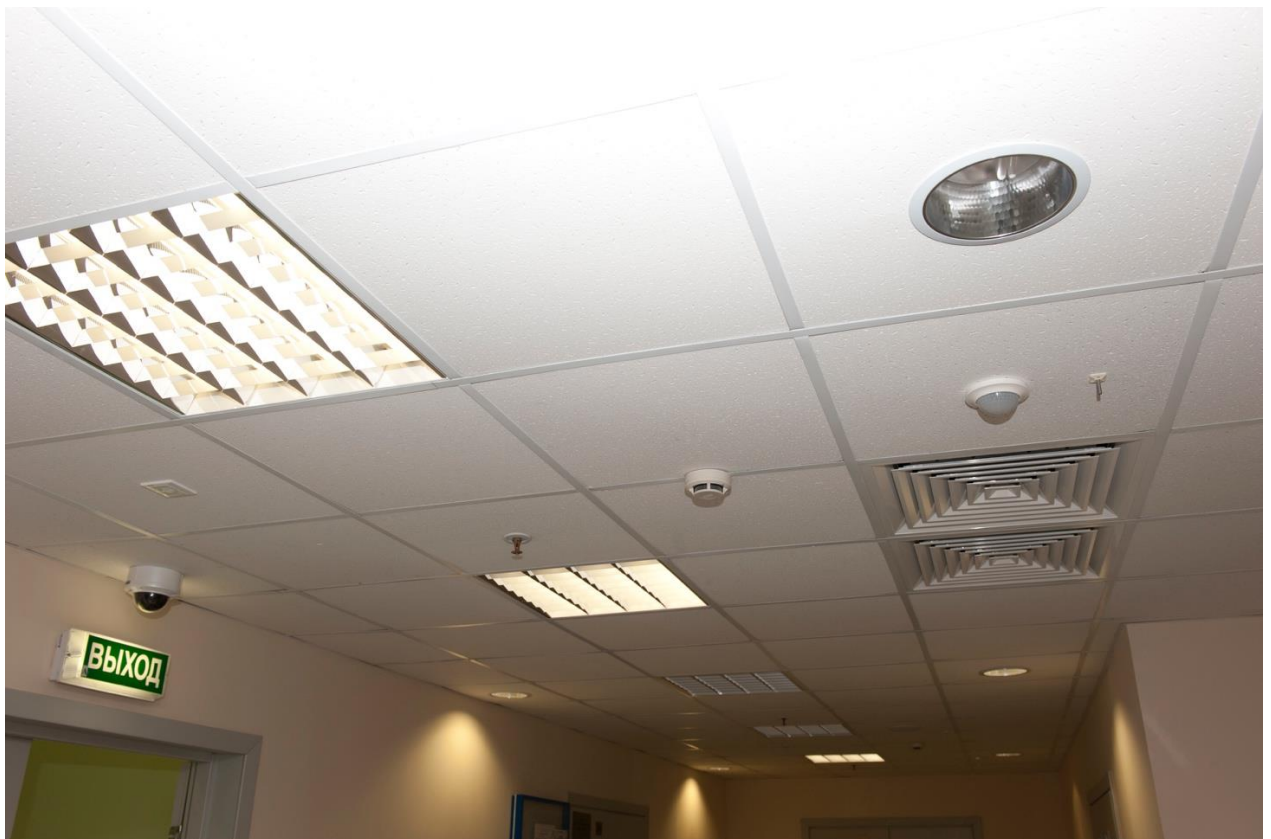
Рис. 4 Инсталлированные датчики в УЛК
