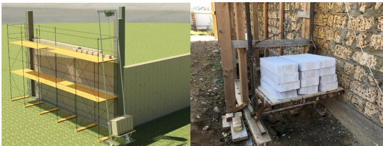
Рисунок 41. Подъёмник каменных материалов, смонтированный на базе унифицированных или индивидуальных лесов (визуализация и фактически реализованный)
