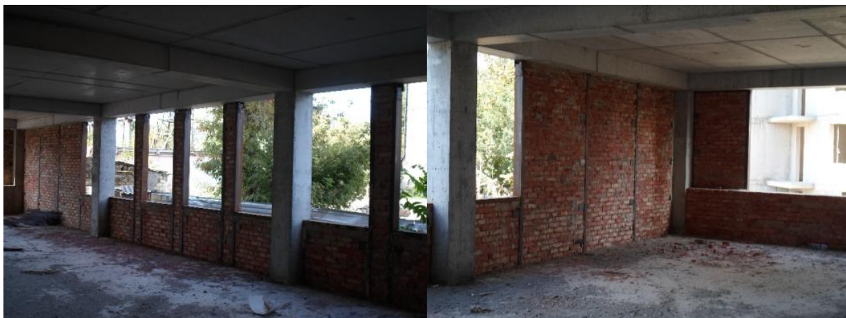
Рисунок 75. Выполненная кладка стен по осям «П», «8»
