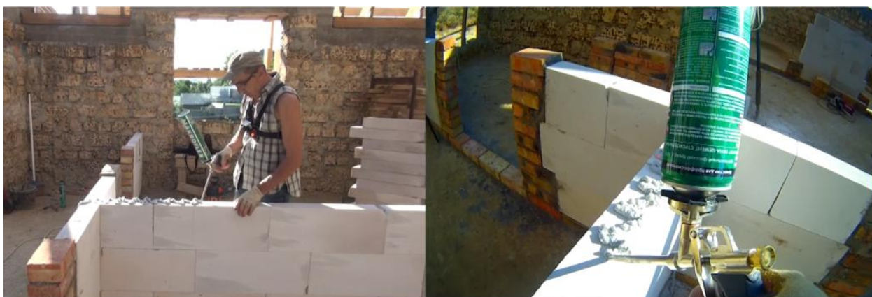
Рисунок 51. Пример зафиксированного видеоряда при нанесении специальной кладочной клей-пены при кладке перегородок
