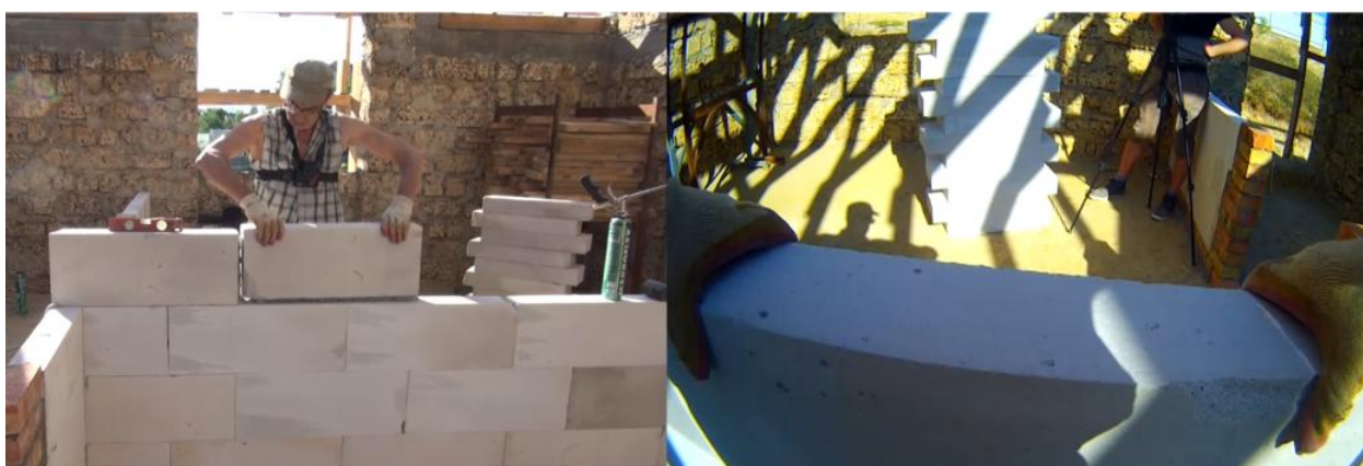
Рисунок 52. Пример зафиксированного видеоряда при нанесении специальной кладочной клей-пены при кладке перегородок
