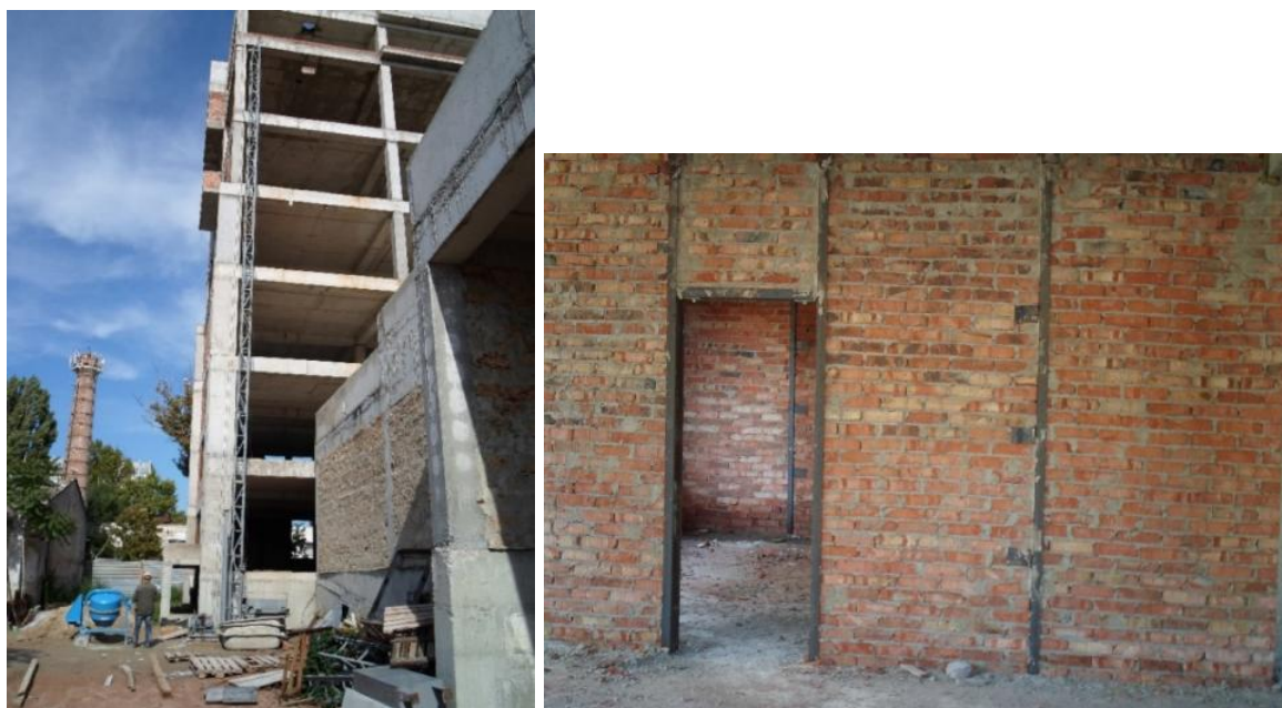
Рисунок 74. Установленный на объекте мачтовый подъемник. Выполненная кладка перегородок в осях «К», «М»
