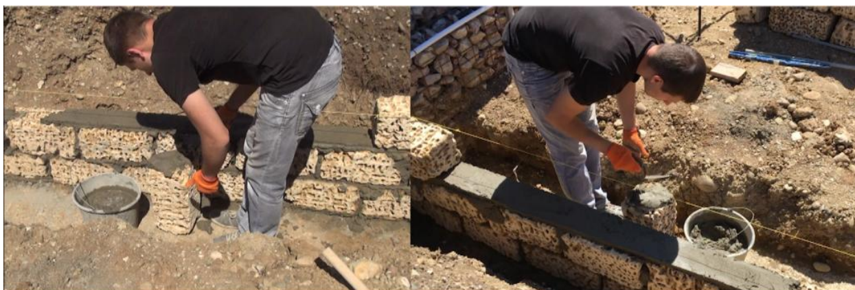
Рисунок 49. Пример зафиксированного видеоряда при кладке из подпорной стены из известняковых блоков на цементно-песчаном растворе
