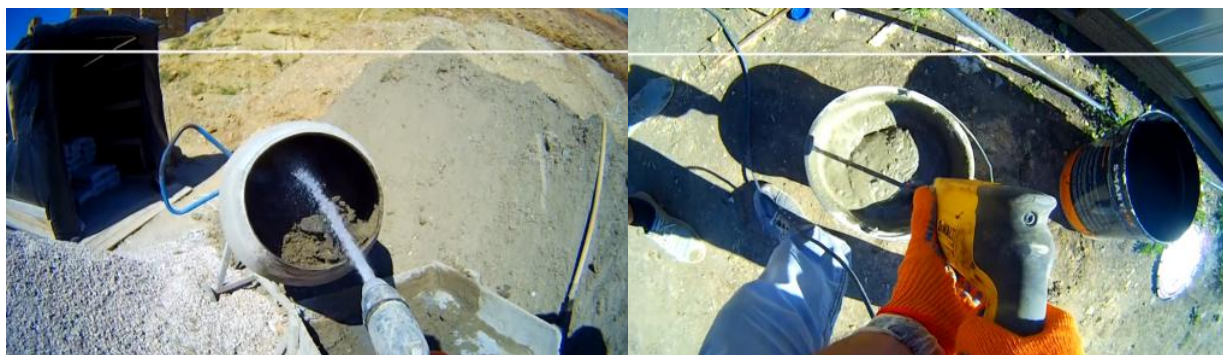
Рисунок 48. Приготовление и перелопачивание цементно-песчаного раствора
