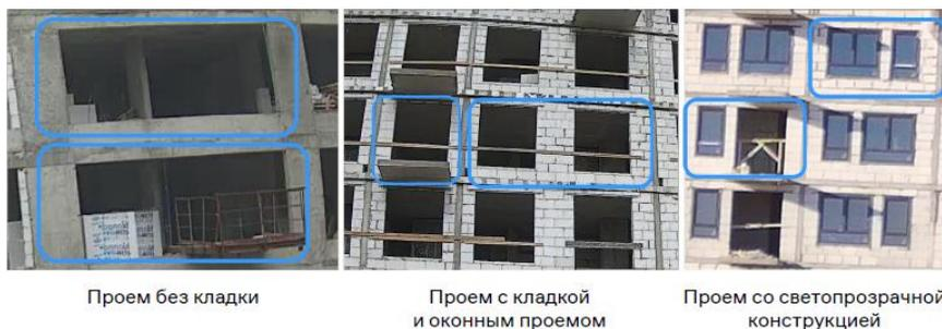
Рисунок 3 - Примеры различных этапов возведения оконных проемов
