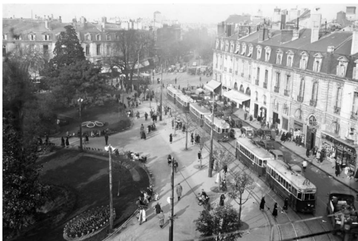
Рисунок 3 – Территория до реконструкции
