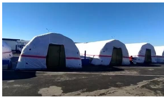
Рис. 1. Быстровозводимое жилье на основе разных технологий. а- жилой комплекс «Соколики» в г.Сокол технология CLT панели, б-«палаточные городки» МЧС Россия технология ткань на метало каркасе.
