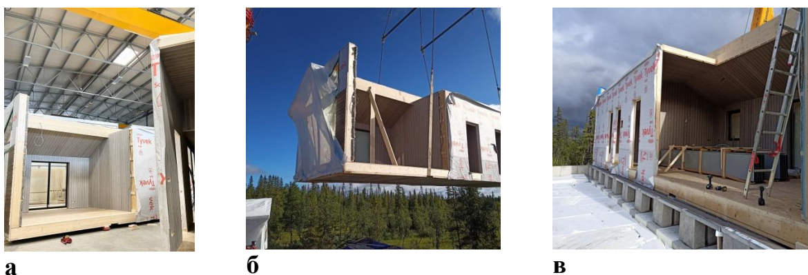
Рис. 2. Технология «PREFAB» Россия а-монтаж оборудования в цехе, б-транспортировка модуля, в- установка модуля на фундамент.
