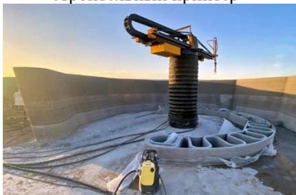
Рис.7 Крановый принтер
