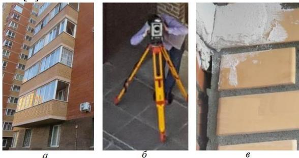
Рис.2. Деформации монолитных железобетонных балконных плит (а), определяемые при проведении геодезической съемке (б) и трещины между стеной здания и кирпичным ограждением балкона (в)
