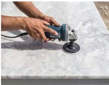
Рис.2. Процесс шлифовки мрамора
