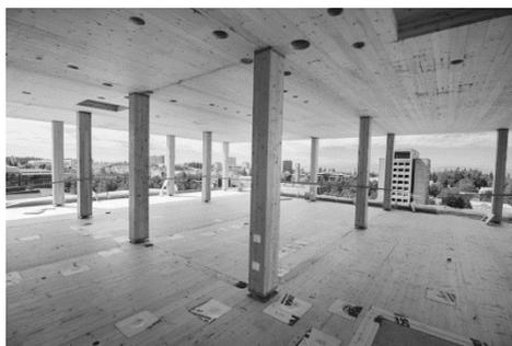
Рис.1 Несущие деревянные конструкции высотного здания
