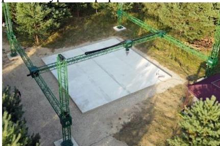
Рис.5 Портальный строительный принтер
