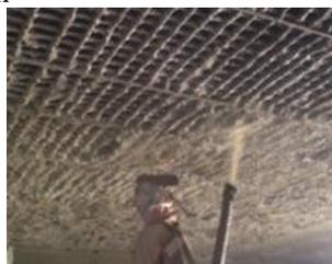
Рис. 4. Торкретирование плиты перекрытия
