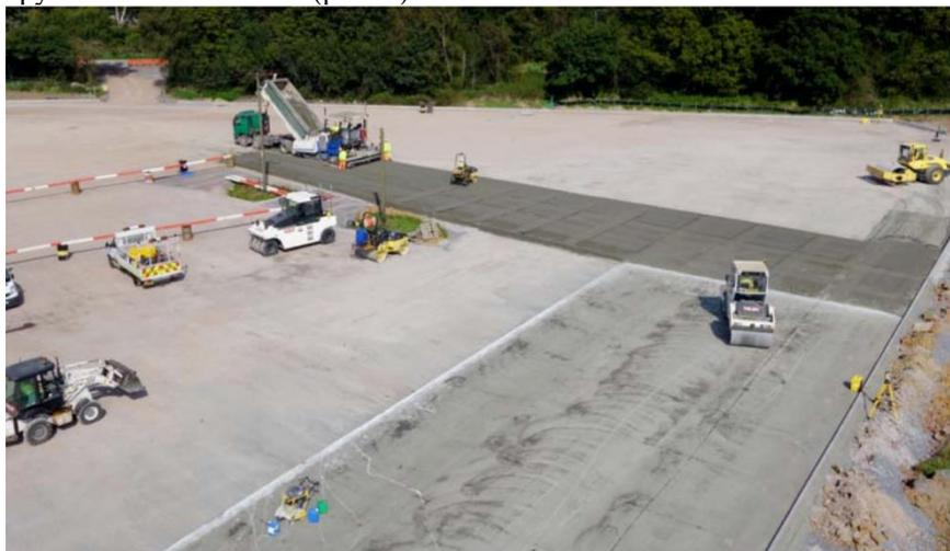
Рис. 1 Конструкции дорожных покрытий повышенной прочности из укатанного бетона в Великобритании
