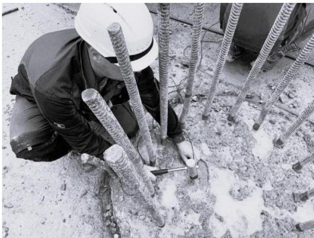
Рис. 1. Определение длины сваи при помощи прибора ИДС-1
