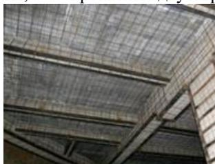
Рис. 3. Комплексное усиление монолитной ребристой плиты (подготовительный этап)
