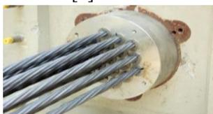
Рис. 2. Анкерное устройство
