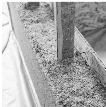
Рис. 3. Заполнение стен костробетоном.
