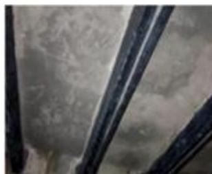
Рис. 2. Усиление ребристой плиты композитными лентами
