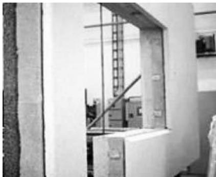
Рис. 1. Многослойная железобетонная стеновая панель
