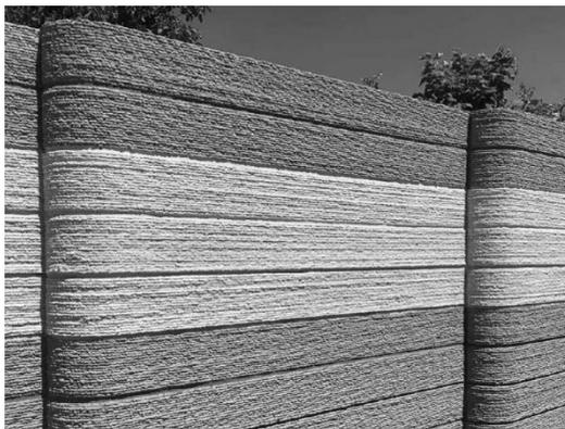
Рис.3. Стены, напечатанные на 3D-принтере
