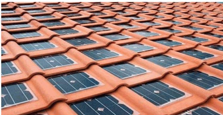
Рис. 1. Крыша здания с встроенными фотоэлементами.
