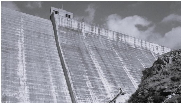
Рис. 2. Плотина Сен-Винсент, Сан-Диего, построенная по технологии укатанного бетона
