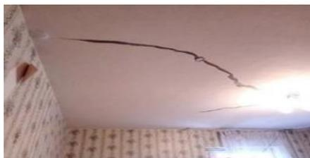
Рис. 1. Трещина, вызванная плохой вибрацией бетона и дальнейшим проникновением воды в нее.
