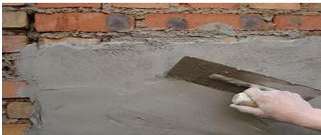
Рис 1. Нанесение штукатурки на кирпичную стену.
