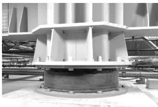
Рис. 1. Резинометаллическая опора колонны
